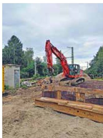
Weder zu übersehen noch zu überhören: Bauarbeiten entlang der S4-Gleise.
