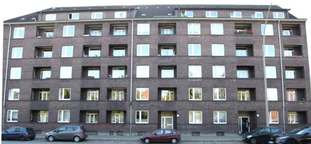
Abb. 53 Vertikal- bzw. Horizontalgliederung der Fassade durch Balkonachsen bzw. Brüstungsesimse im Wohnungsbau der 1920er Jahre, hier in der Eiffestraße in Hamm
