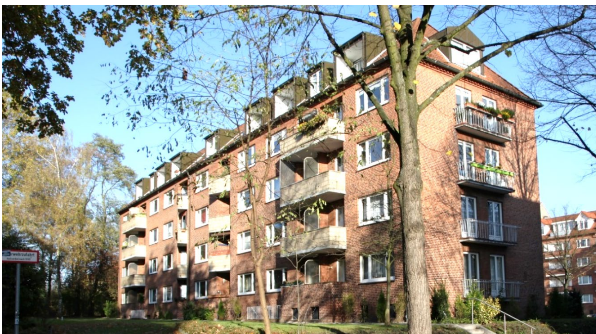
Abb. 55 Horn, Dunckersweg: Zeilenneubauten der 1950er Jahre mit gelb gefliesten Balkonbrüstungen
