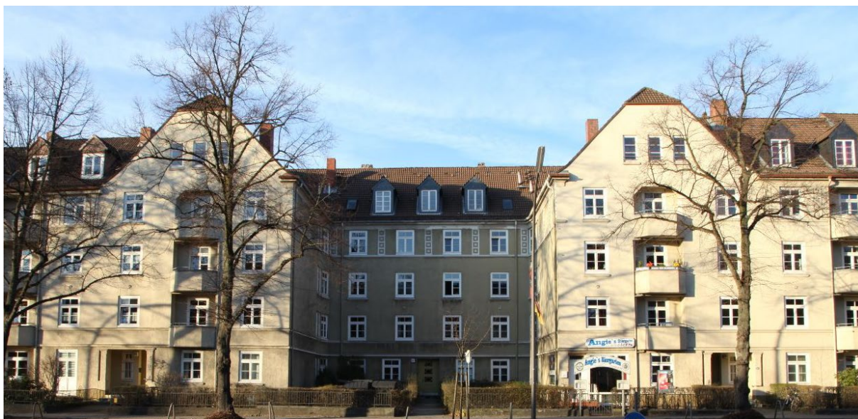
Abb. 65 Hamburger Hof als Putzbau im Heimatstil mit Ehrenhof zur Sievekingsallee
