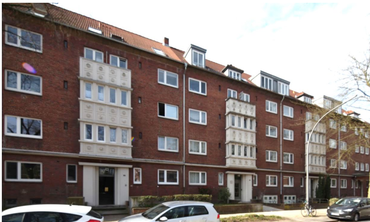
Abb. 45 Backsteinbau mit traditionalistischen Gestaltungselementen aus Werkstein in der Washingtonallee, Horn (1936-37)
