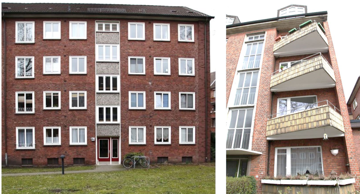
Abb. 56 Mosaikfliesen in der Treppenhausachse, vertikal gestellte Fenster und doppelflügelige, asymmetrisch geteilte Eingangstüren und ausgestellte Balkone mit gelb gefliesten Brüstungen bilden nur einen Teil der gestalterischen Vielfalt in der Fassadengestaltung der 1950er und 1960 Jahre, hier in der Carl-Petersen-Straße in Hamm
