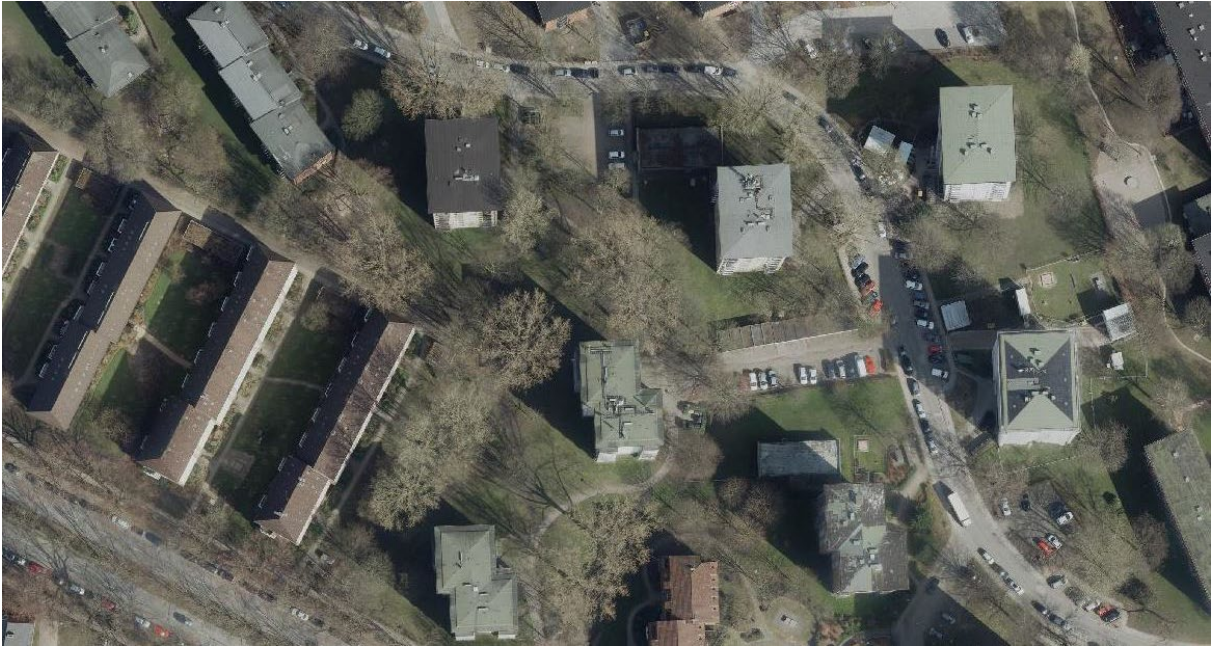
Abb. 49 Das Grünsystem der Nachkriegszeit fasst Gebäude und Baugruppen in „fließenden“ Grünräumen zusammen (Luftbild, 2019 © FHH, LGV)
