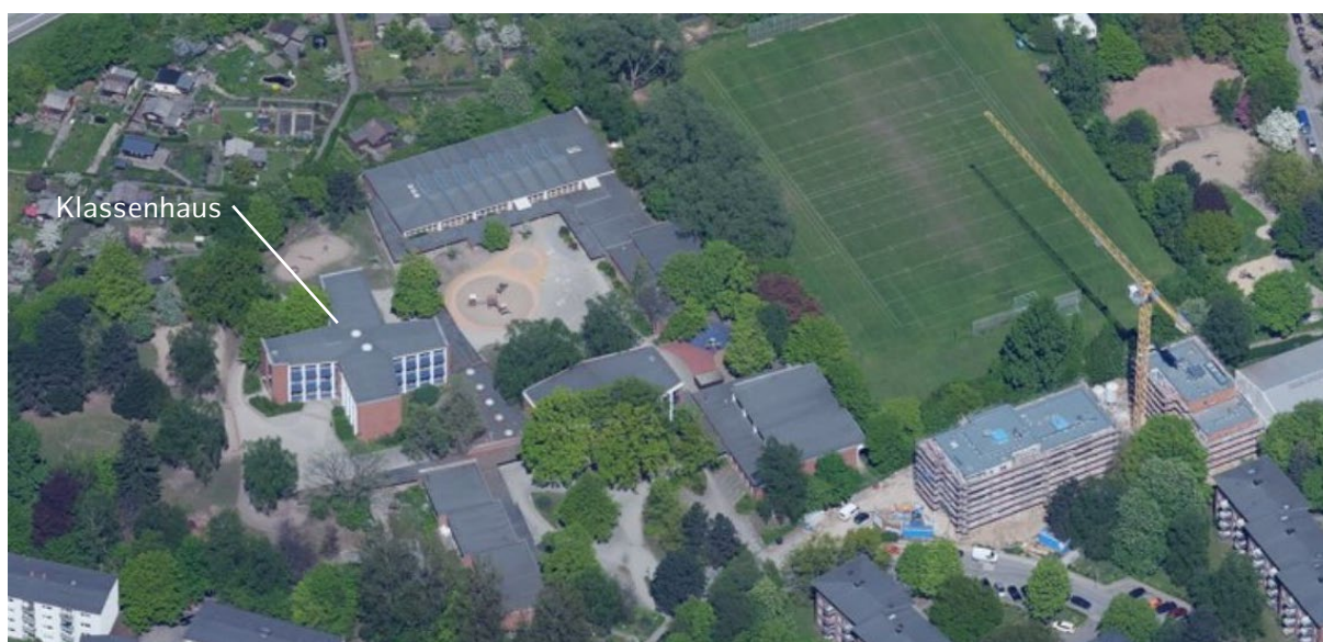
Abb. 73 Grundschule Horn mit typischem kreuzförmigem Klassenhaus, Pavillons und gegliederten Außenräumen (Schulgebäude: Paul Seitz; Schrägluftaufnahme © FHH, LGV)
