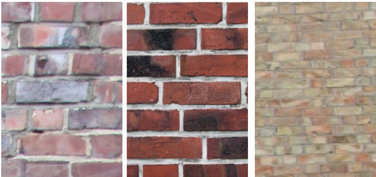
Abb. 31 Lilafarbener Klinker (Zwischenkriegszeit), ziegelroter und gelber/geelscher Backstein (Nachkriegszeit) mit Kohlebrandzeichnung und weißem bzw. grauem Fugennetz
