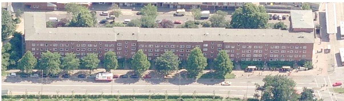
Abb. 40 Neues Bauen südlich der Horner Rennbahn von Norden: raumteilendes Ensemble an der gleichnamigen U-Bahnstation (Schrägluftaufnahme © FHH, LGV)
