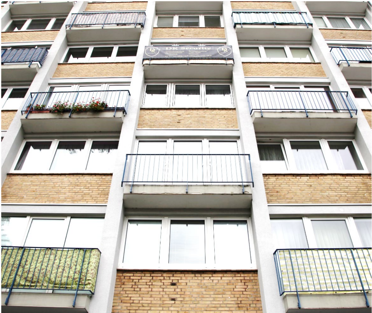
Abb. 60 Hochhaus Pagenfelder Platz: Stahlbetonfachwerk, wechselweise ausgefüllt mit bodentiefen Fenstern und Balkon sowie mit gelbem Backstein ausgemauerten Brüstungsfeldern
