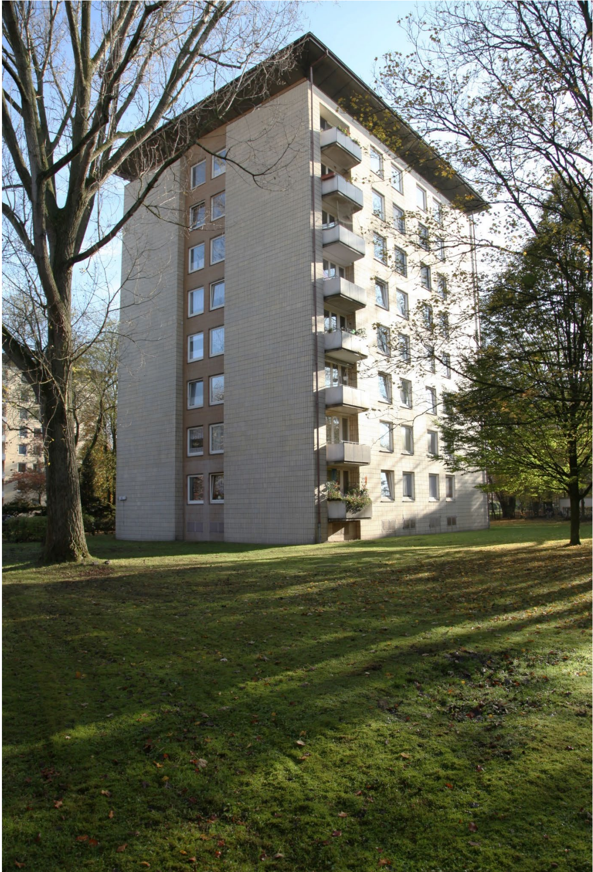
Abb. 57 Horn, Rhiemsweg: Neubau der 1950/60er Jahre mit Flugdach, farblich abgesetzten gelben Fliesen (heute überformt) innerhalb proportional zur Höhenentwicklung erweiterten Freiflächen (Entwurf: Heinz Dorendorf, Baujahr: 1957–60)
