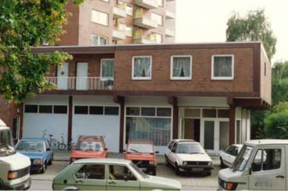
Noldering, 1992: Hier entsteht unsere Kita.
