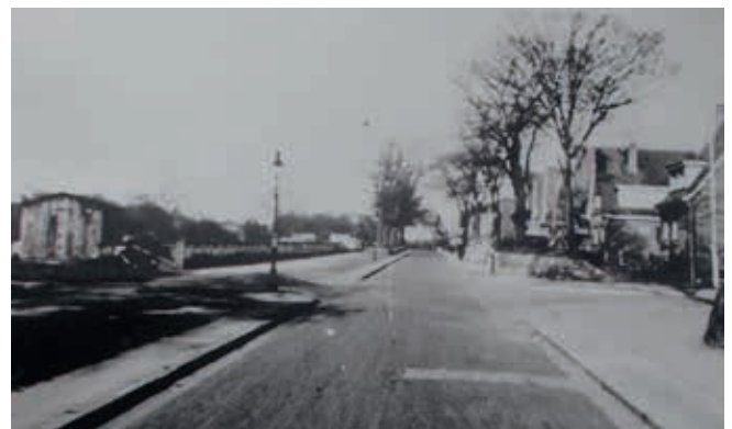
Heilholtkamp Ecke Frühlingsgarten in Richtung Sengelmannstraße – 1937
