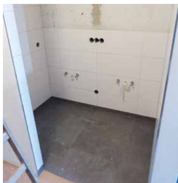
Sanierung der Nassbereiche im Bayernhaus
