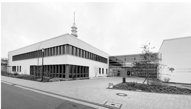
Schulneubau am Richard-Linde-Weg
