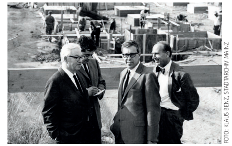
Arne Jacobsen und Otto Weitling an der Baustelle des Rathaus Mainz
