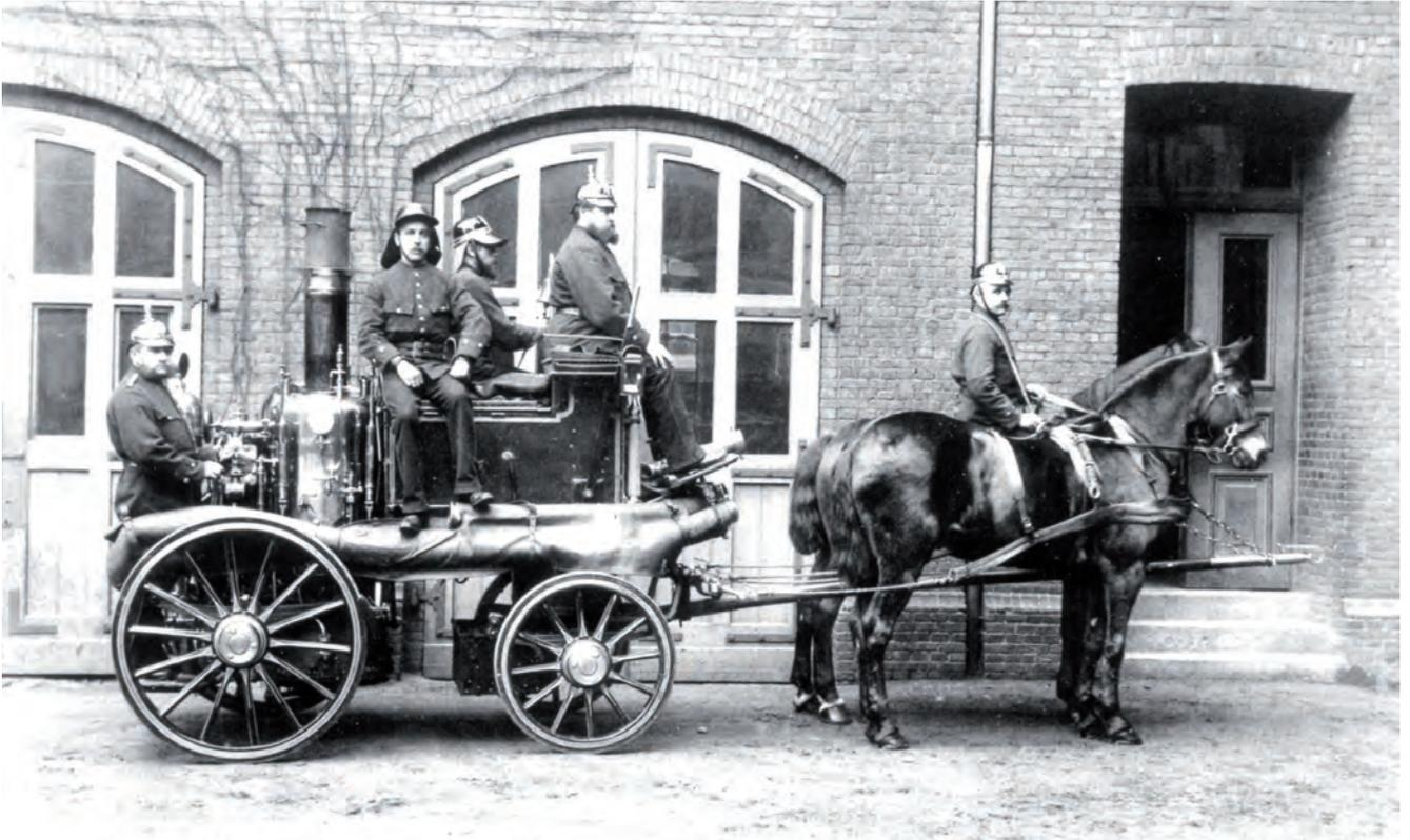
**Fünf Mann und zwei PS:** Die pferdebespannte und kohle- oder holzbefeuerte Dampfdruckspritze – 1872 Stand der Technik
