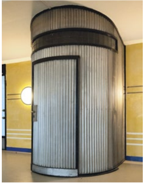
Wie schon in Dessau, unterstützte die Firma Junkers innovative Architektur mit ungewöhnlichen Materialien, wie hier zum Beispiel das durch Wellenform stabilisierte Aluminium.
