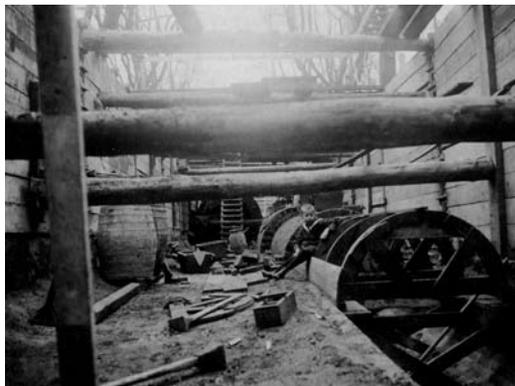
Gleich nach der Eingemeindung Groß Borstels wurde in den Jahren 1913-16 die Besielung ausgeführt. Das Foto rechts zeigt einen Blick in die "Unterwelt": Die Rohrleitungen werden verlegt. Fotos: Wanser, 1913
