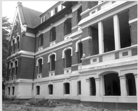
Die Baustelle Martinistraße 44 im Jahr 2018
