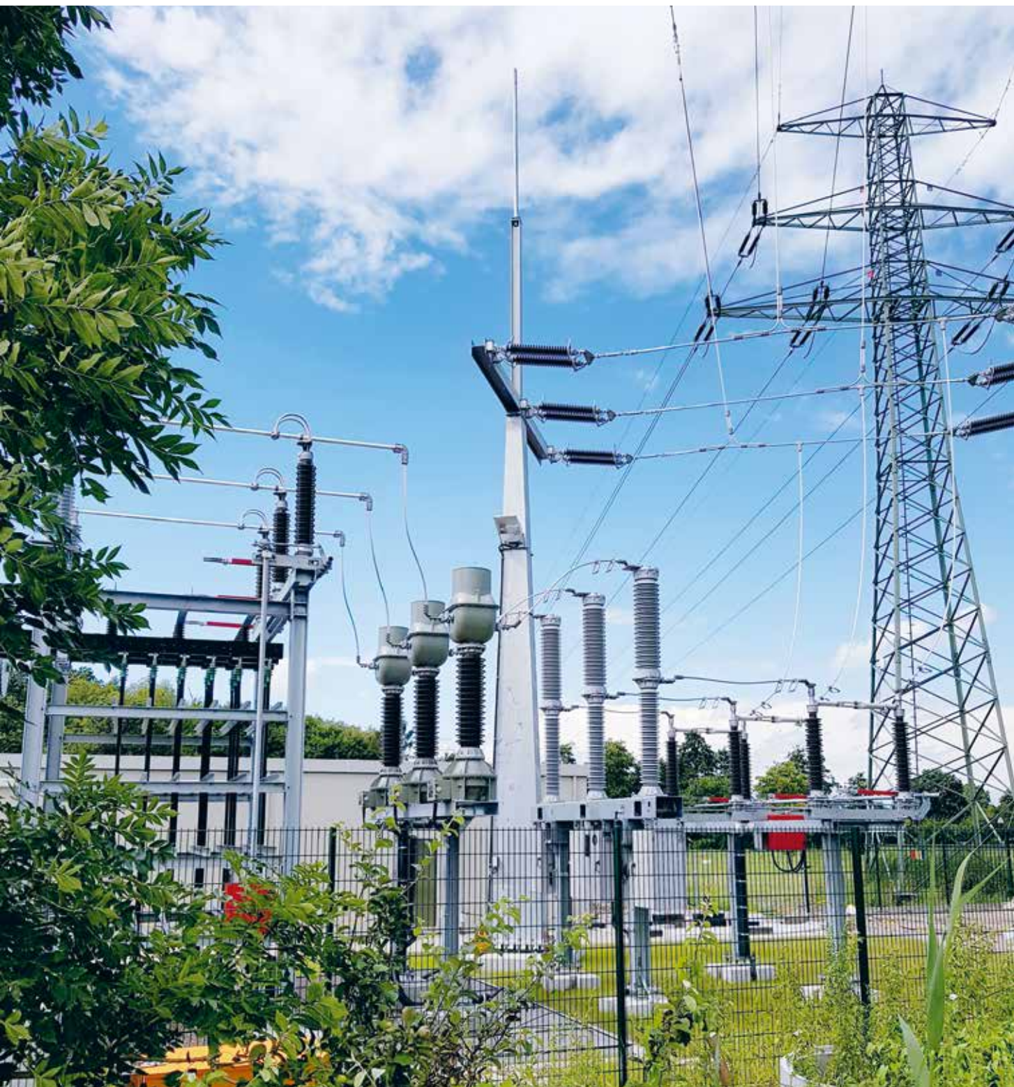
Freiluftschaltanlage
