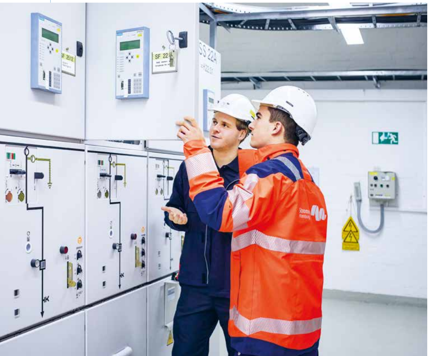
Begehung des Umspannwerks Bramfeld
