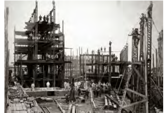
Für den Bau des Speicherblocks H in der entstehenden Speicherstadt werden Eisenträger hochgezogen. Bauarbeiter nutzen einfach zusammen genagelte Holzleitern zum Besteigen der Großbaustelle, und per Handwagen kann Baumaterial über provisorische Gleise transportiert werden.
