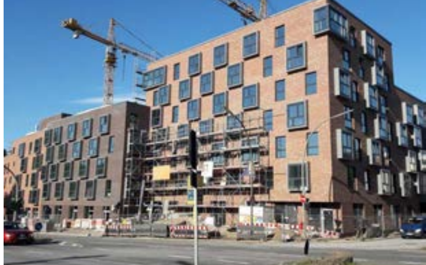
Neubau Kattunbleiche Quelle: Bezirksamt Wandsbek
