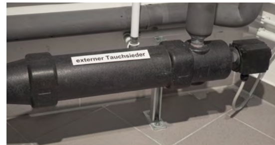
Variante 2: Elektroheizstab mit Schwerkraftumlauf außerhalb des Wärmespeichers.
