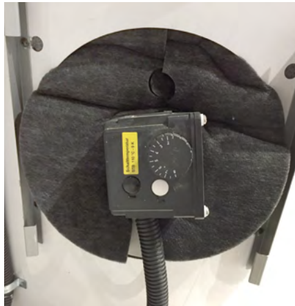
Variante 1: Elektroheizstab direkt unten im Wärmespeicher eingebaut.
