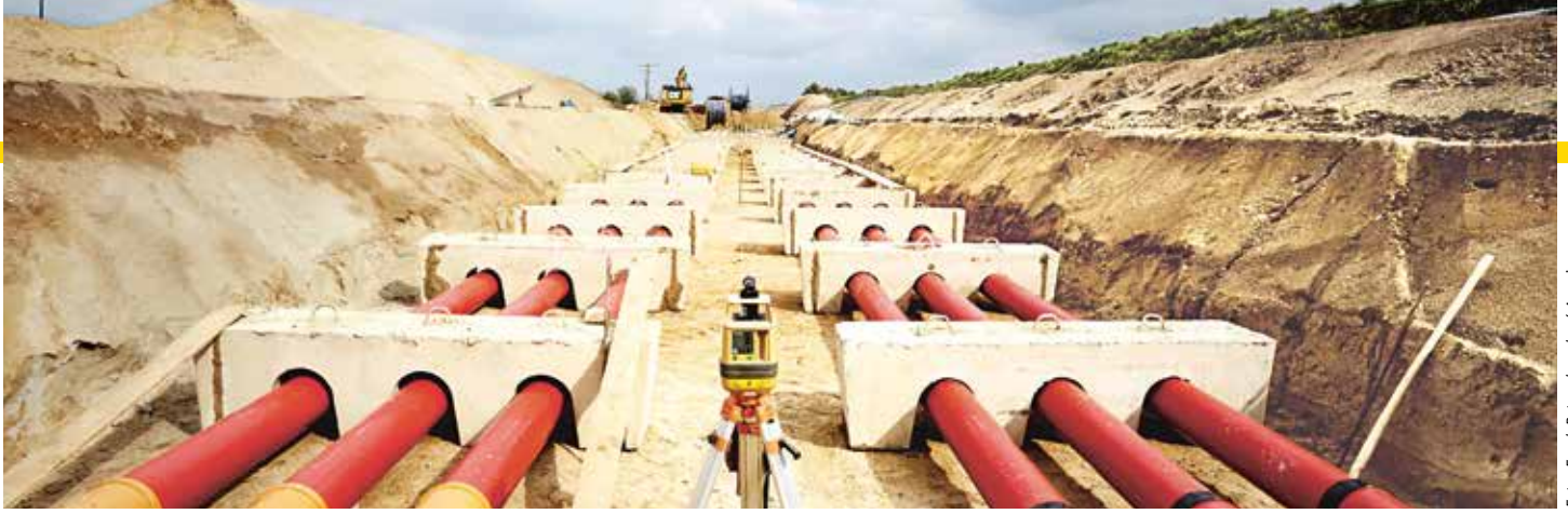
Erdkabelbau bei Raesfeld
