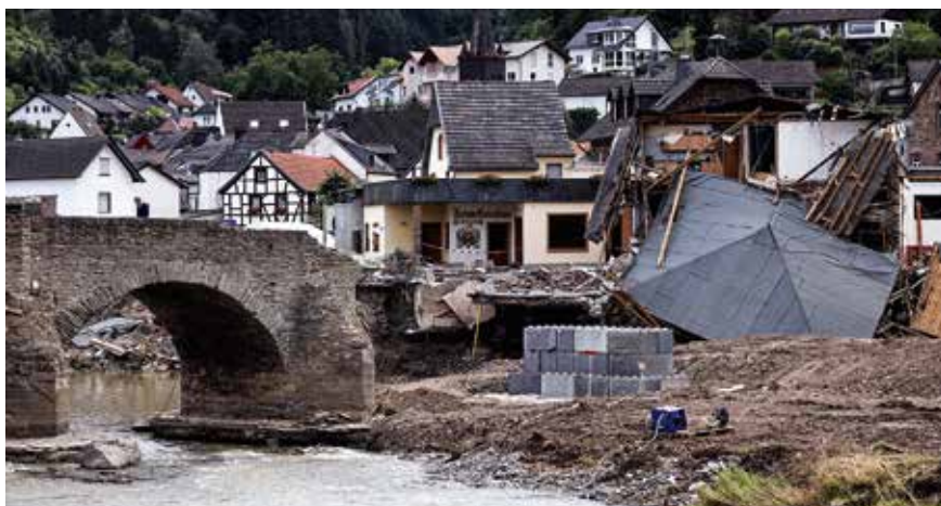
Große Zerstörung Die Bauwirtschaft will schnell mit dem Wiederaufbau beginnen.
