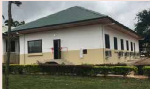
Das neue Laborgebäude von KCCR und BNITM im Agogo Presbyterian Hospital
