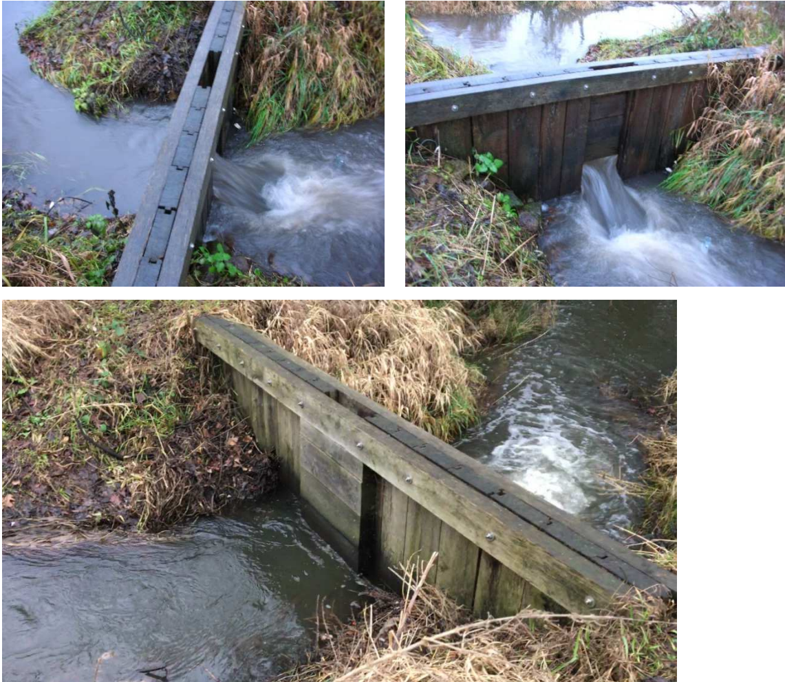
Abb. 20: Fotos des Holzschützes bei der Verzweigung der Mühlenau in ihren alten Gewässerlauf. Die Aufnahmen zeigen den rückstauenden (ingeschnürten) Abfluss.
