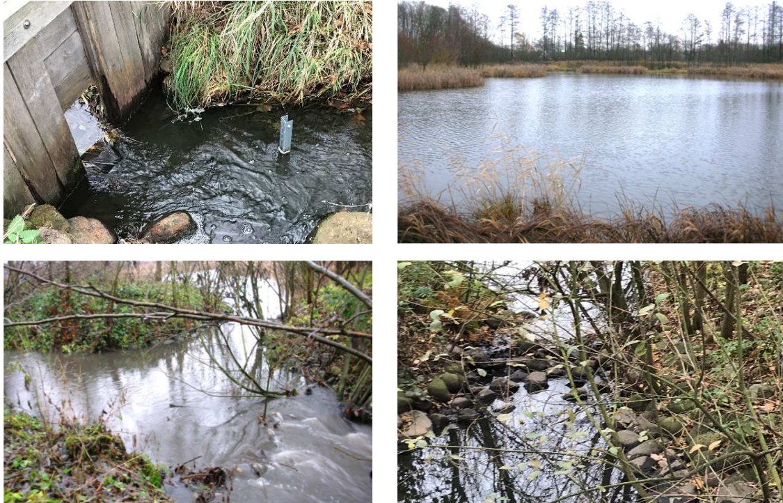
Abb. 16: Fotos der drei Steuerungselemente: Holzschütz, HRB Retentionsraum Mühlenau, überströmtes Wehr am Auslass bei hohem und bei niedrigem Wasserstand im HRB.
