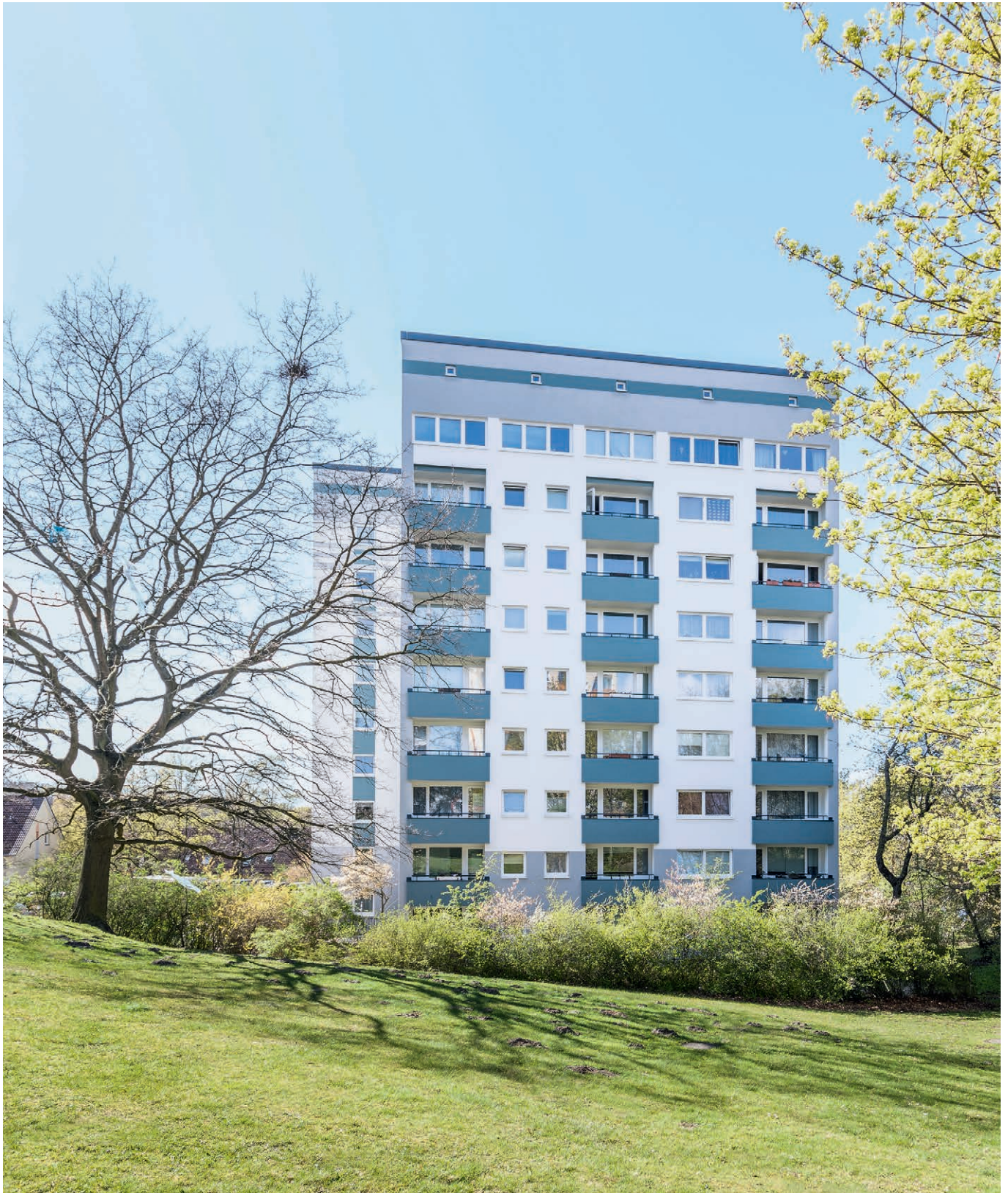
Modernisierte Fassade im Berkefeldweg 2
