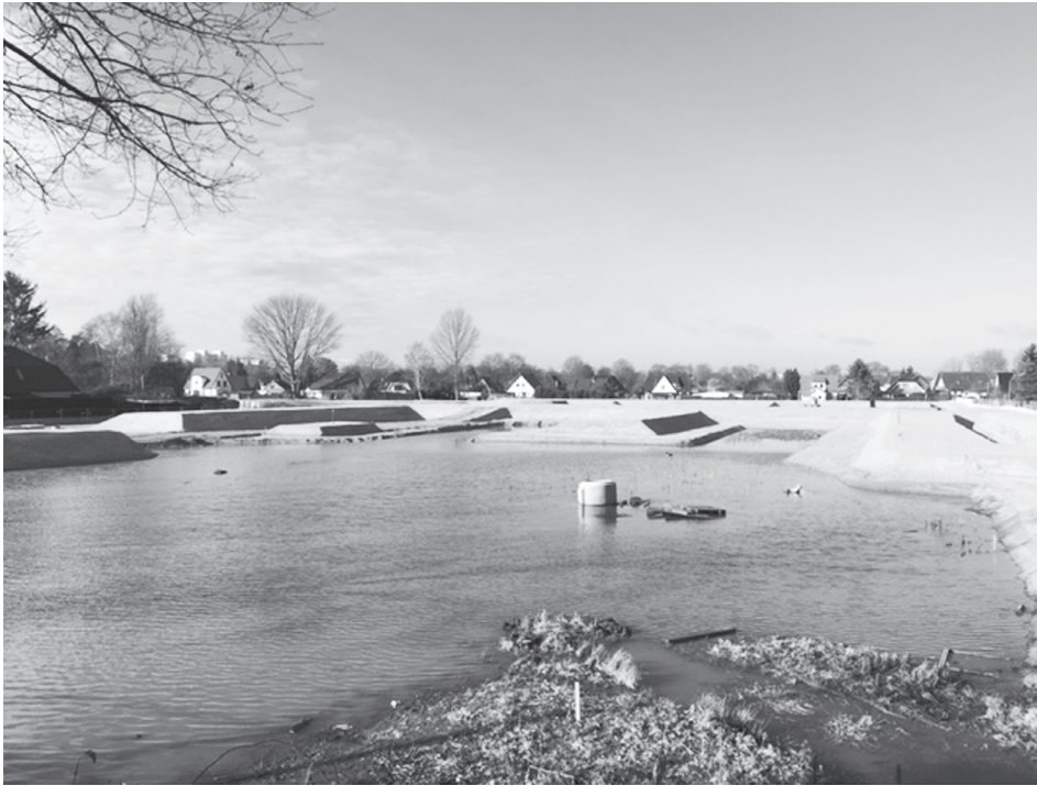
Die Großbaustelle Kirchenwiese. Durch den Baustellenteich sieht es im Moment fast ein wenig aus wie nach der Flut ...
