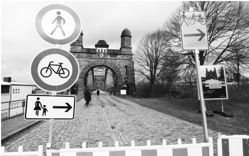
Alte Harburger Elbbrücke, Richtung Wilhelmsburg: Umleitung bis Ende des Jahres. Foto: hk
