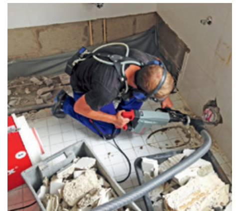
Personengetragene Fasermessung beim UVT-Messprogramm „Asbest in Putz- und Spachtelmassen“
