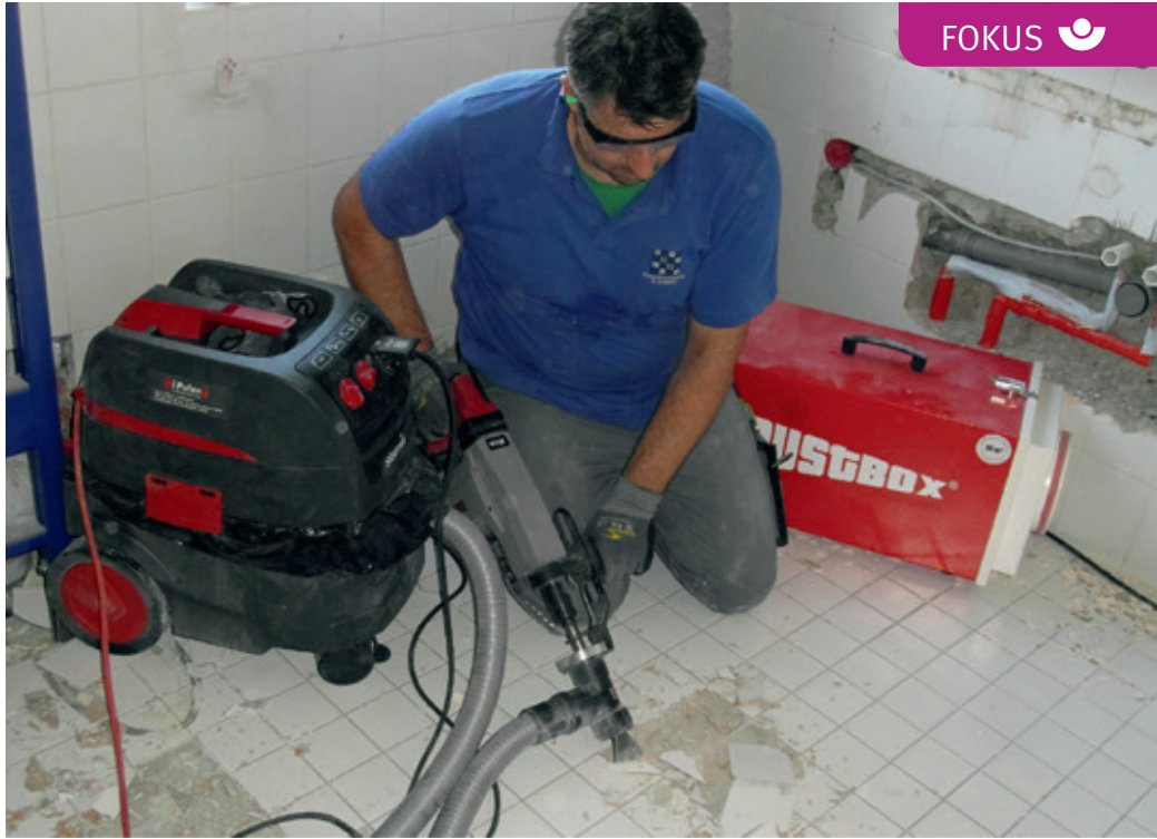
Staubarmes Entfernen von Bodenfliesen mit abgestimmten Bearbeitungssystemen (Maschine und Mobilentstauber) und Luftreiniger
