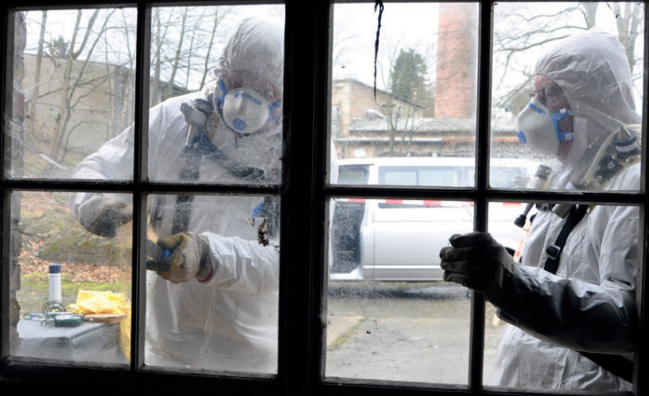
Wer asbesthaltigen Fensterkitt emissionsarm aus Fensterflügeln oder Festverglasungen entfernen will, muss dabei auf elektrisch betriebene fräsende, oszillierende oder schleifende Maschinen verzichten.
