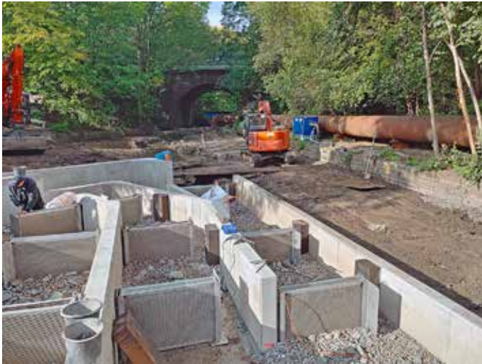
Der Fischaufstieg in der Bauphase kurz vor Fertigstellung.
