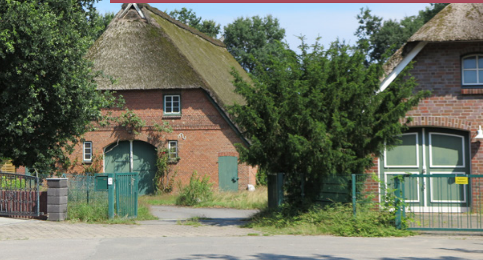
Alte Bauern-Häuser im Stadt-Teil
