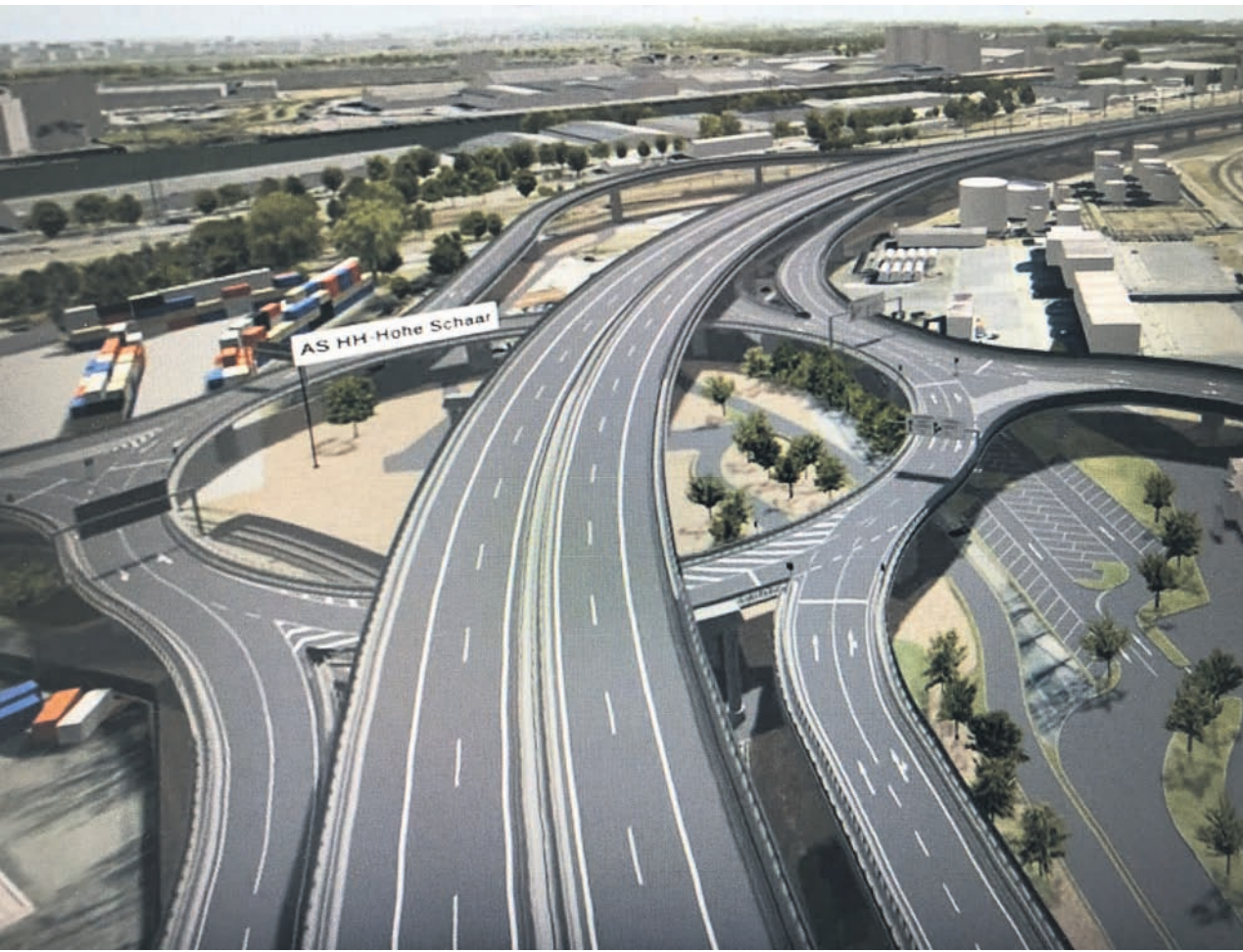
Diese Ansicht auf dem Laptop zeigt den geplanten Kreisell Hohe Schaar – eine bundesweit einmalige Konstruktion in drei Ebenen.
