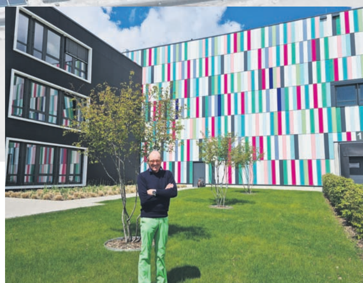
IN-TIME-Inhaber und -Geschäftsführer Christoph Gienow steht vor der Fassade seines Neubaus am Trelder Berg in Buchholz. Die bunte Optik gehört zu seinem Marketingkonzept – jeder, der hier schon einmal vorbeigefahren ist, kennt dieses Gebäude, ahnt aber nicht, wie es auf dem energiegeladenen Dach aussieht ... Foto: Nina Behrens
