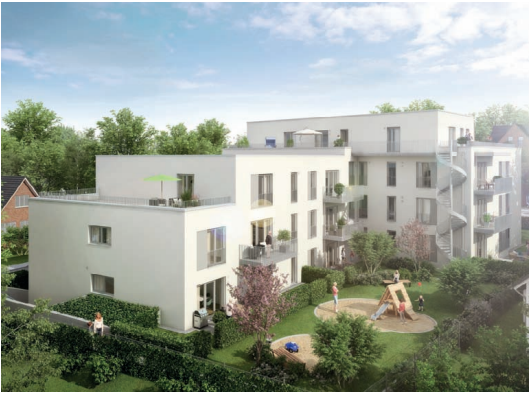
Iserbrook Hus mit Blick in den familiengerecht gestalteten Innenhof
