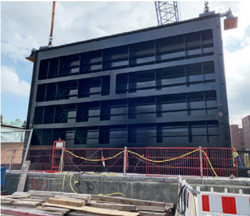
Einhub des neuen fleetseitigen Tores
