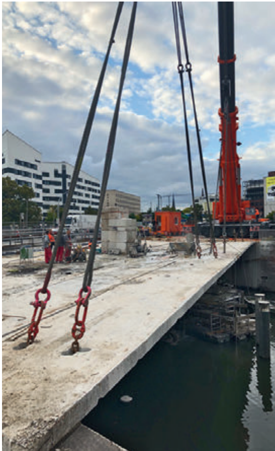
Hohe Priorität für den Lärmschutz: Behutsamer und kleinteiliger Abbruch der Brücke
