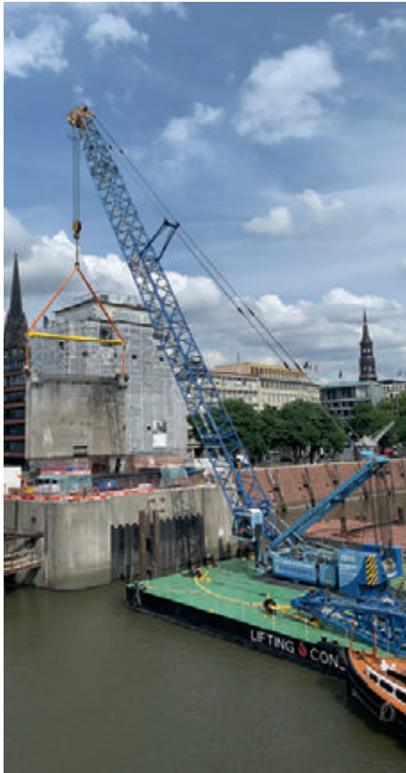
Aushub des alten fleetseitigen Tores
