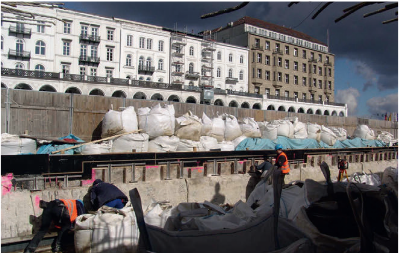
Abbildung oben: Abbrucharbeiten der Treppenanlage
