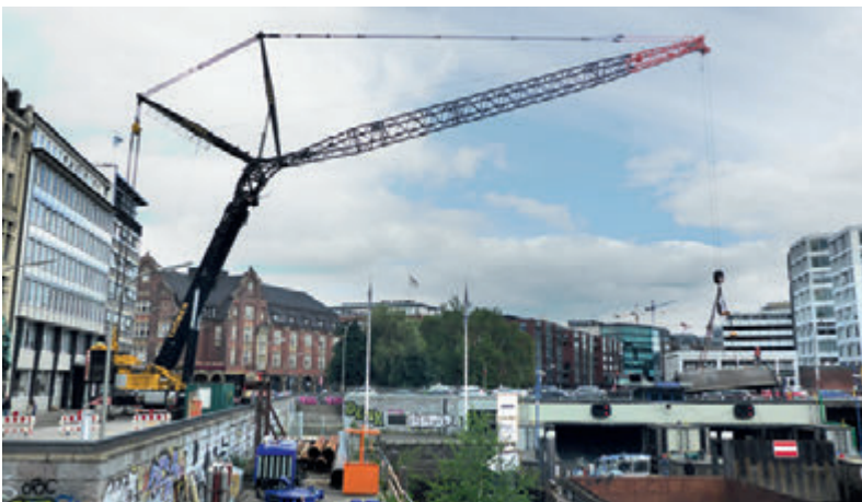
Ausheben des Drehsegmenttors aus der Schleusenammer der Schaartorschleuse
