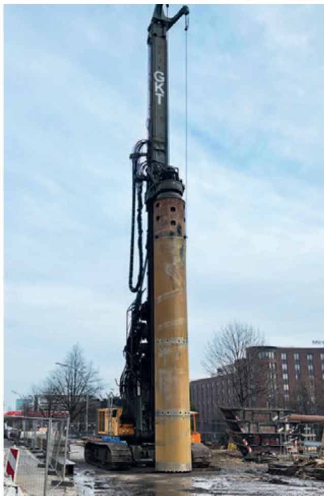
Großbohrpfahlgerät im Einsatz
