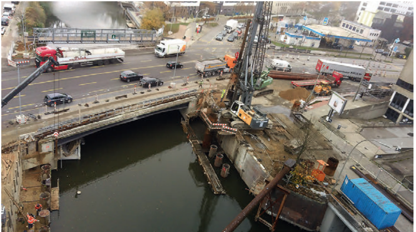
Luftbild während der Tiefgründungsarbeiten
