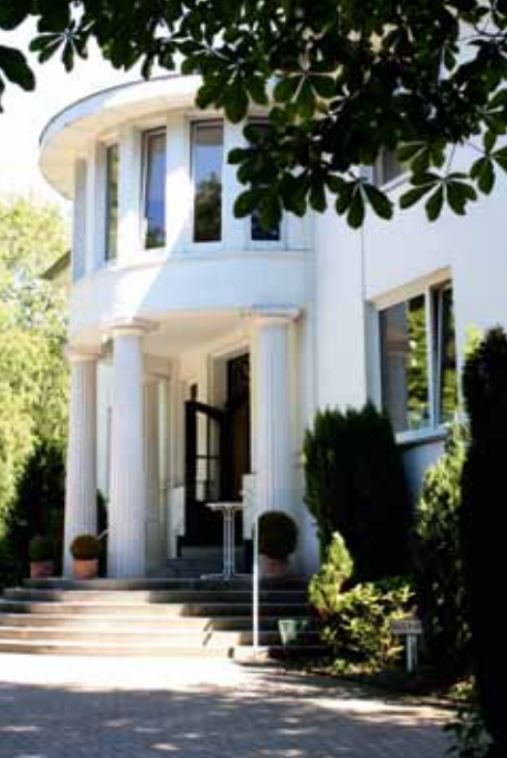
31 Haus Rissen Hamburg
