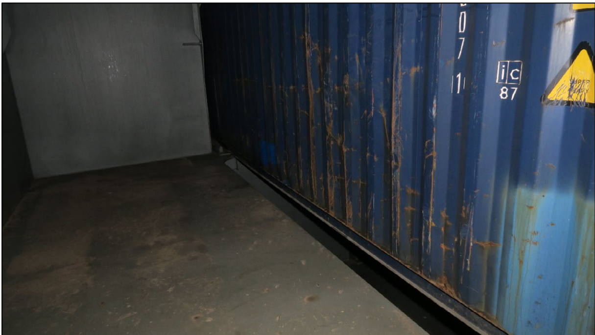
Abbildung 30: Ein noch nicht gegen Absturz gesicherter Bereich 82
