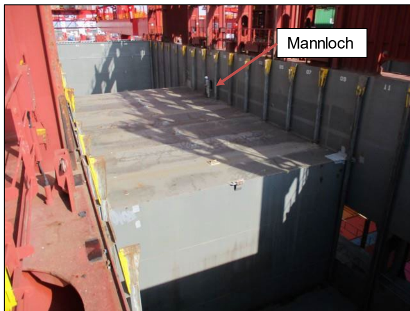
Abbildung 6: Blick auf die Umhausung bei geöffneter Ladeluke von der Stb.-Seite 18
