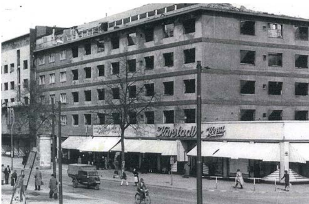
Kriegszerstörung / Wiederaufbau in in der Osterstraße
