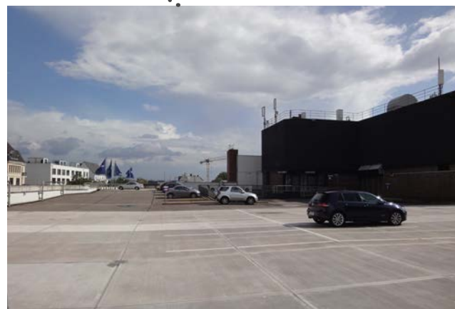
Parkdeck auf dem Karstadt-Gebäude
