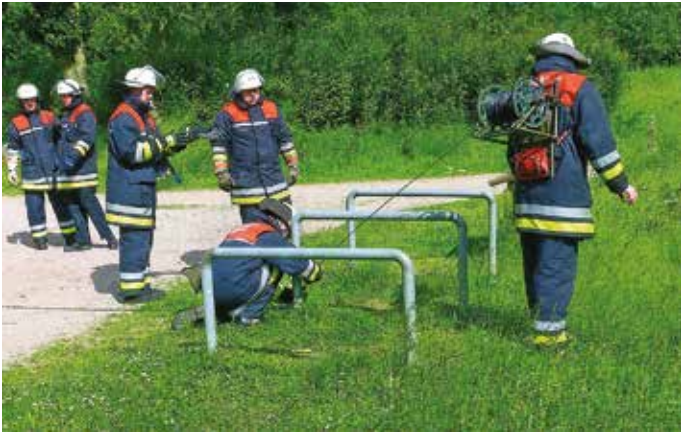
Der Feldkabelbautrupp verlegt eine Telefonleitung auf dem Höltigbaum.
