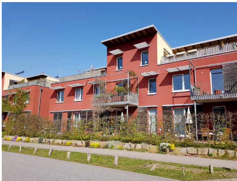
Lockere Bauweise und große Fenster schaffen lichtdurchflutete Räume
