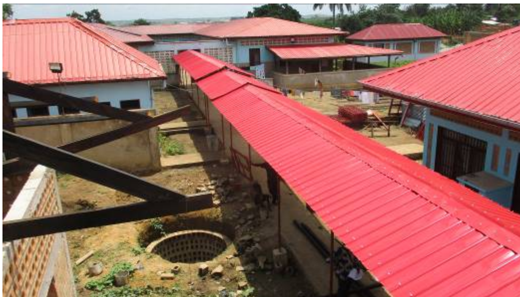
Kinderstation (rechts), überdachter Gehweg (Mitte) und im Bau befindliches Labor (links)
