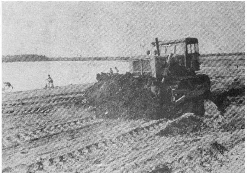
Riesige amerikanische Erdbaumaschinen beginnen 1958 mit den Planierungsarbeiten
