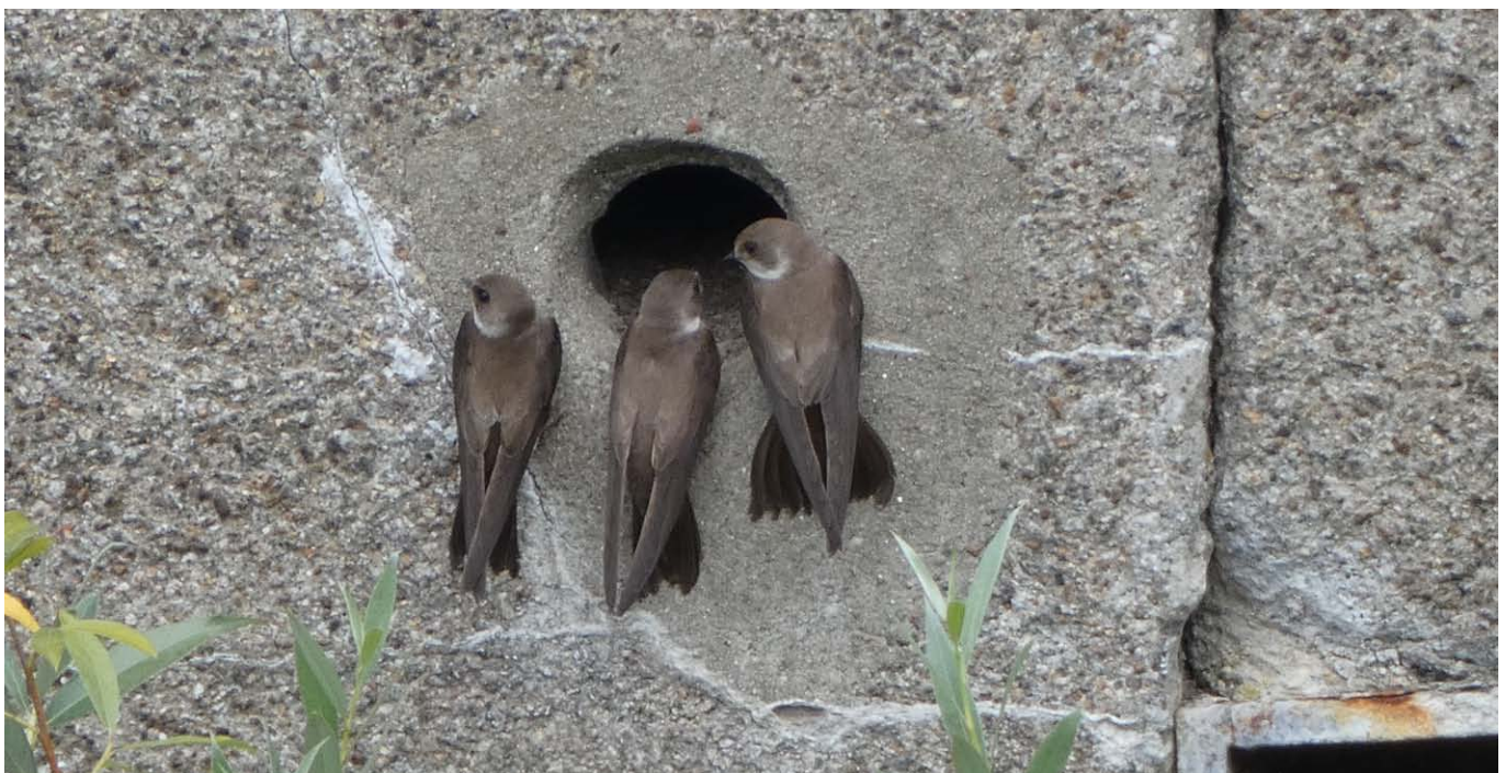
Skuril: Uferschwalben (3 BP!) „in der Betonwand“ - (Hovekanal/HH, 08.07.2021, G. Rupnow)
