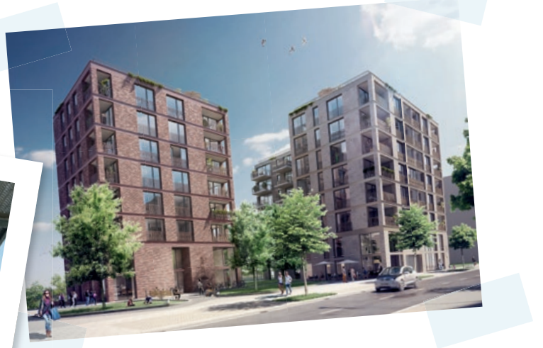
Kurz vor der Fertigstellung: Saskia Steffen aus der Technischen Abteilung der altoba betreut den Neubau Baufeld 90 a. Unten: Visualisierung Baufeld 96 a/b.
