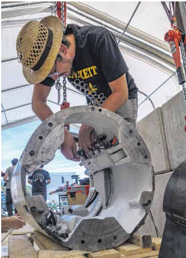
Ein E-Techniker installiert die Hydraulik des Bohrkopfs. „TUM Boring“ setzt sich aus verschiedenen Teams von Spezialist*innen zusammen.
