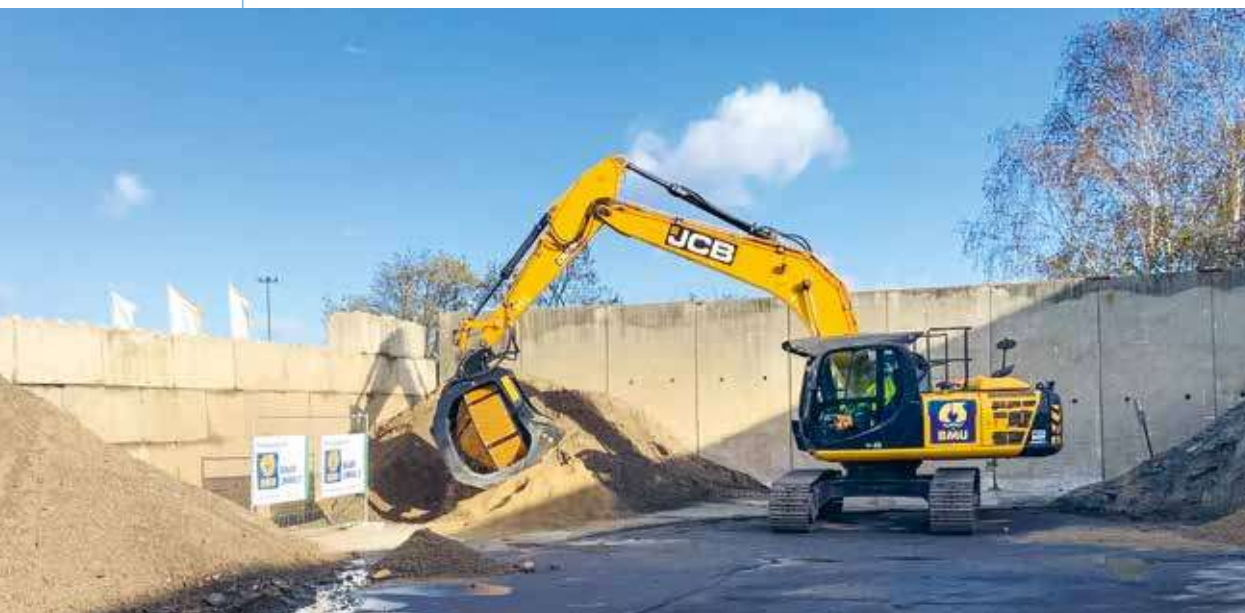
Siebvorgang beim Bodenaushub
