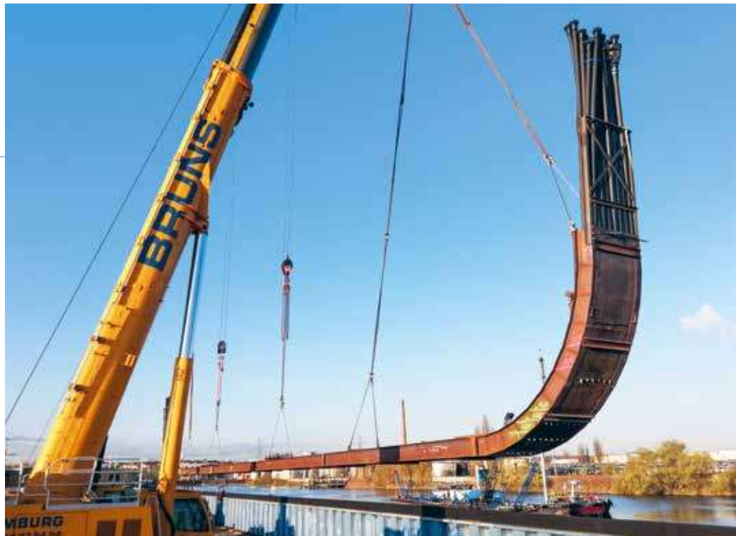
Sanierung Kabeldüker Lotsekanal / Rückbau 110-kV- Freileitung 2020/21
