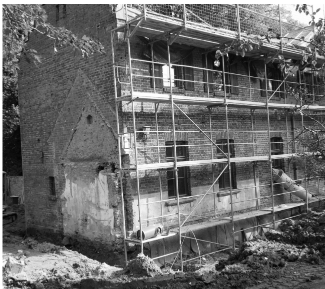
Abb. 3: Fassaden und Dachsanierung, in der historischen Fassade mussten ca. 2500 Steine in mühevoller Handarbeit ausgetauscht werden (Brehms Welt – Jochen Süß)
