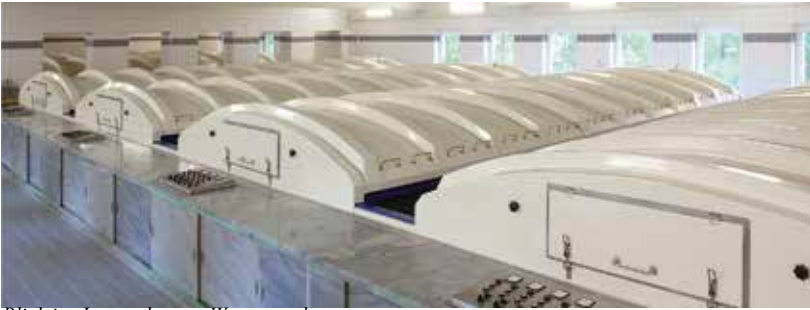
Blick ins Langenhorner Wasserwerk
