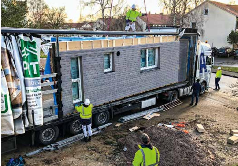
**Fassade aus Vorfertigung** In Hameln wurde erstmals in Deutschland nach dem Energiesprong-Verfahren saniert. Dieses soll den Klimaschutz im Gebäudesektor auf eine neue Stufe bringen.
