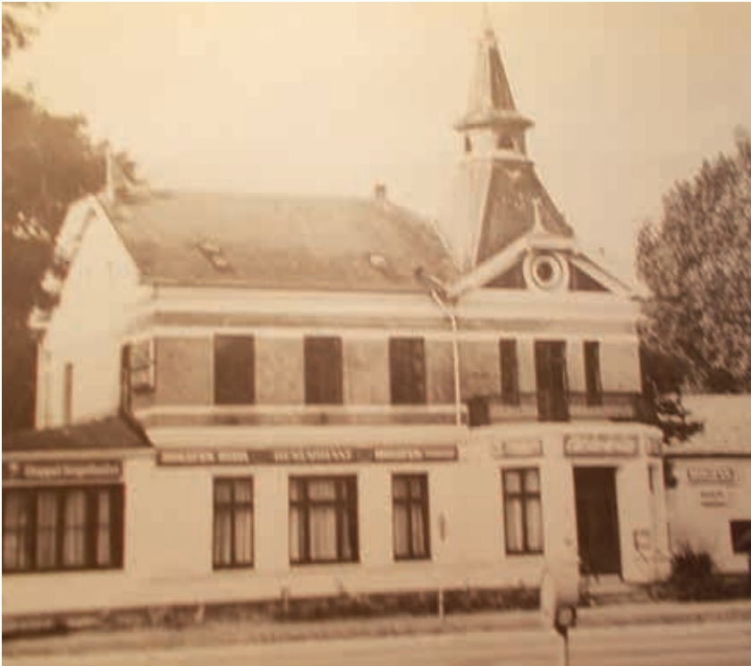
Noch einmal die Straßenseite mit dem markanten Turm, der in ähnlicher Form auch beim Hotel-Neubau wieder zu sehen und in dem heute der Aufzug eingebaut ist.
