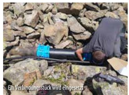
Ein Verbindungsstück wird eingesetzt
