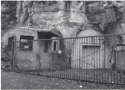
Eingang zum NORTHAG-2ATAF-Führungsbunker südlich Maastricht
