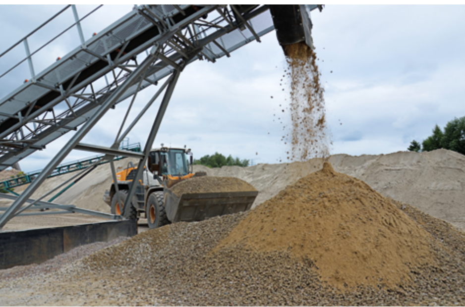
Nachschub für die Baubranche: Sande und Kiese werden in großen Mengen für viele Bauprojekte benötigt. Doch der Rohstoff ist endlich. Foto: RBS Firmengruppe
