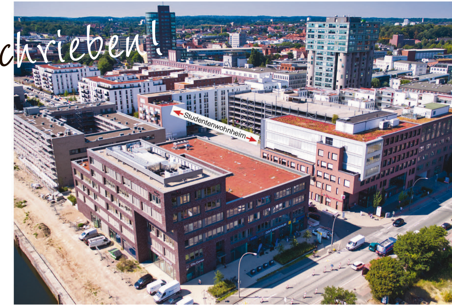
Jetzt wird die Lücke geschlossen: Hier an der Theodor-Yorck-Straße soll das „Gabriel Riesser Haus“ gebaut werden – ein Wohnheim für Studenten.
