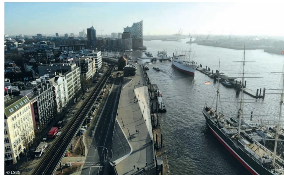
Der Bauablauf war im ersten und zweiten Bauabschnitt prinzipiell ähnlich. Die neue Hochwasserschutzwand wurde 4 bis 7,50 Meter vor die alte Hochwasserschutzwand gebaut. Die Promenade rückt also etwas weiter in die Elbe hinein.
