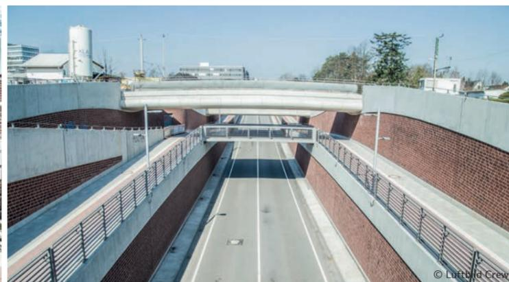
Da der Gleichgewichtszustand im Bereich seitlicher Trogblockaufweitungen für die seitlichen Geh- und Radwegausgänge (Claudiusstieg und Trauns Allee im südlichen Abschnitt) gegenüber einem „normalen“, unter Auftrieb liegendem, symmetrischen Block nicht vorhanden war, mussten u.a. zusätzliche statische Nachweise geführt werden. Abhilfe schaffte hier der Einbau zusätzlicher Sohlensporne über die mehrere Meter dicke Sohle auf der gegenüberliegenden Seite.
