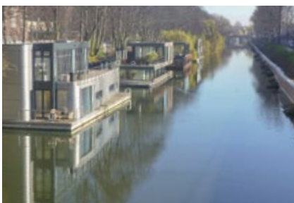
oben: Die neue Uferwand unten: Hausboote vor der neuen Uferwand
