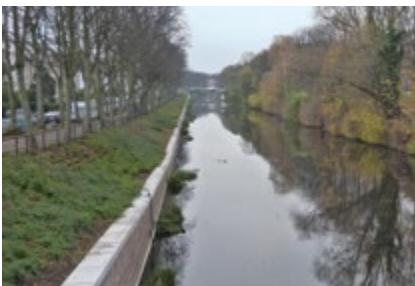
Alte Bestands-Uferwand auf der rechten Seite
