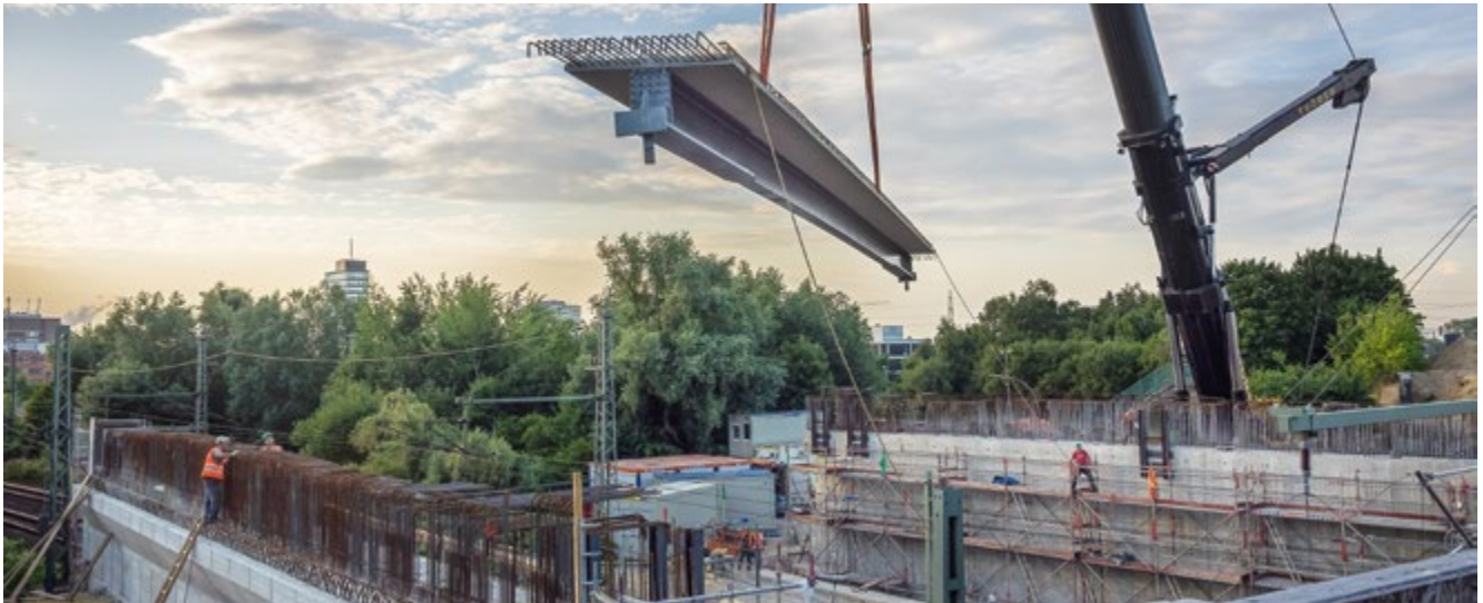
Einbau der Längsträger während einer 2-tägigen Sperrpause
