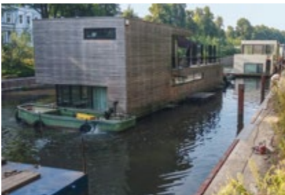
oben: Neue Spundwand vor der alten Uferwand unten: Verlegung eines Hausbootes
