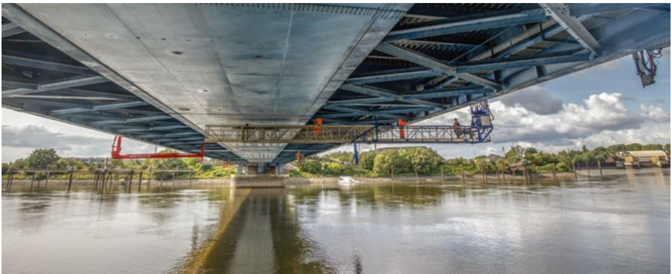
Alle sechs Brückenuntersichtsgeräte im Einsatz
