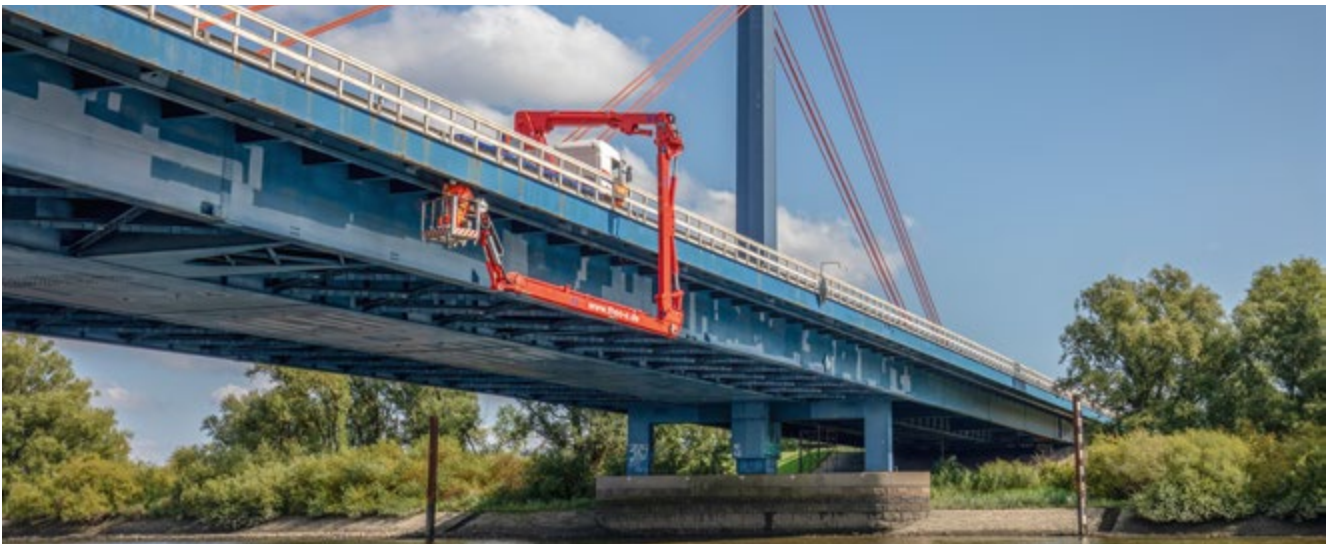
Die Norderelbbrücke – wichtige Lebensader im Skandinavienverkehr
