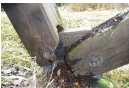
oben: Typische Brücke im Stadtteil unten: In die Jahre gekommener Pfeilerfußpunkt
