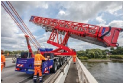
Eines von sechs Brückenuntersichtsgeräten baut sich auf
