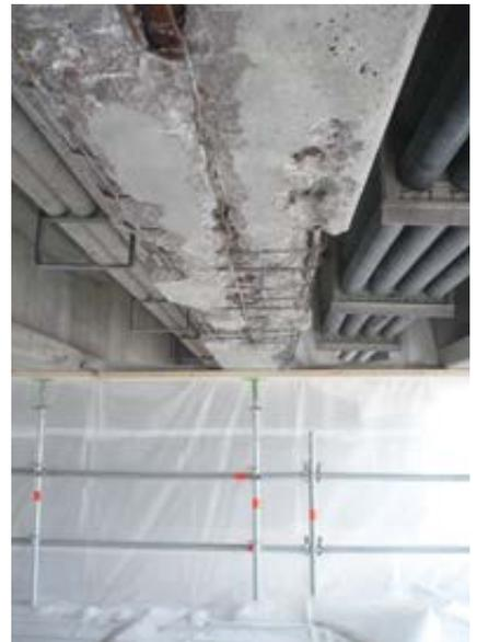
Betonschäden an der Brückenuntersicht
