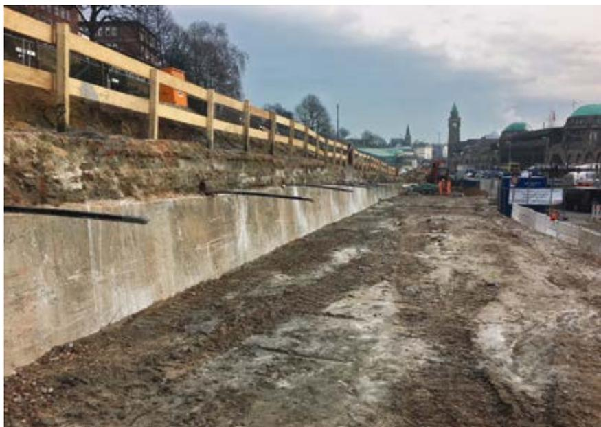
Spritzbeton auf altem Mauerwerk
