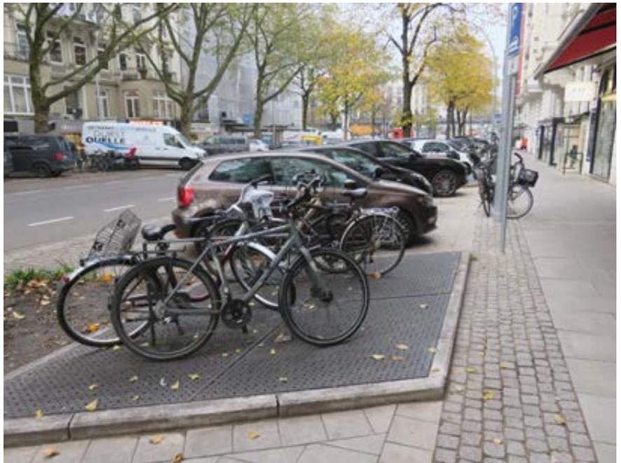
Baumscheibe mit Stahlrost und darauf montierter Fahrradbügel
