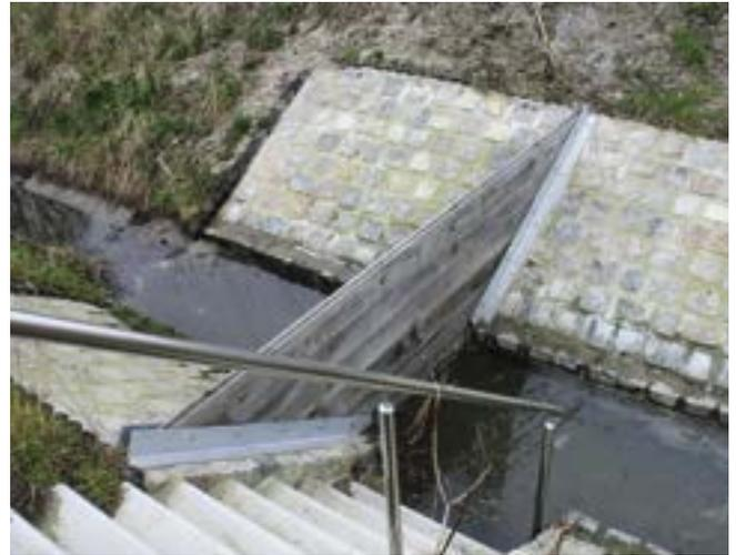
Beispiel einer offenen Anlage mit Sedimentationsbereich und Leichtstoffsperr
