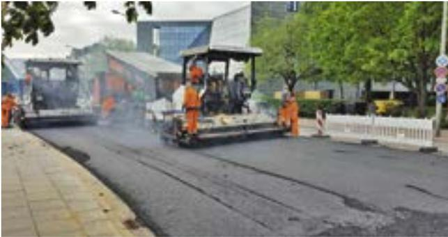
Gestaffelter Fertigereinsatz beim Asphalt einbau
