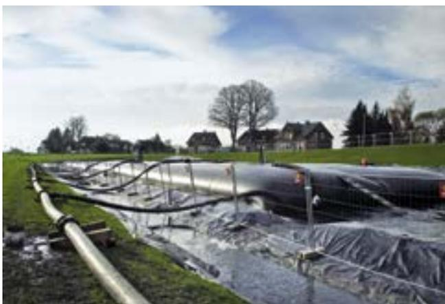
Gefüllte Entwässerungssäcke mit Schlammförderleitungen
