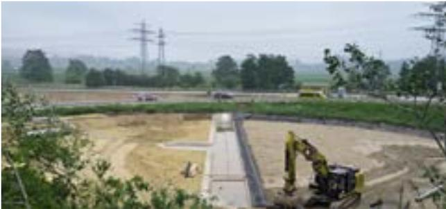
Regenrückhaltebecken mit Sedimentationsbereich und Bodenfilter
